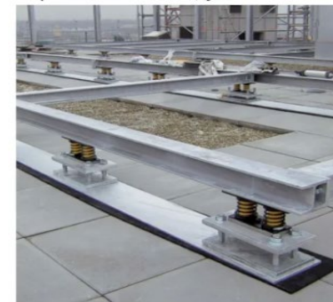
Пружинный демпфер под трехэтажным домом
