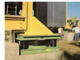
Пружинный демпфер под трехэтажным домом
